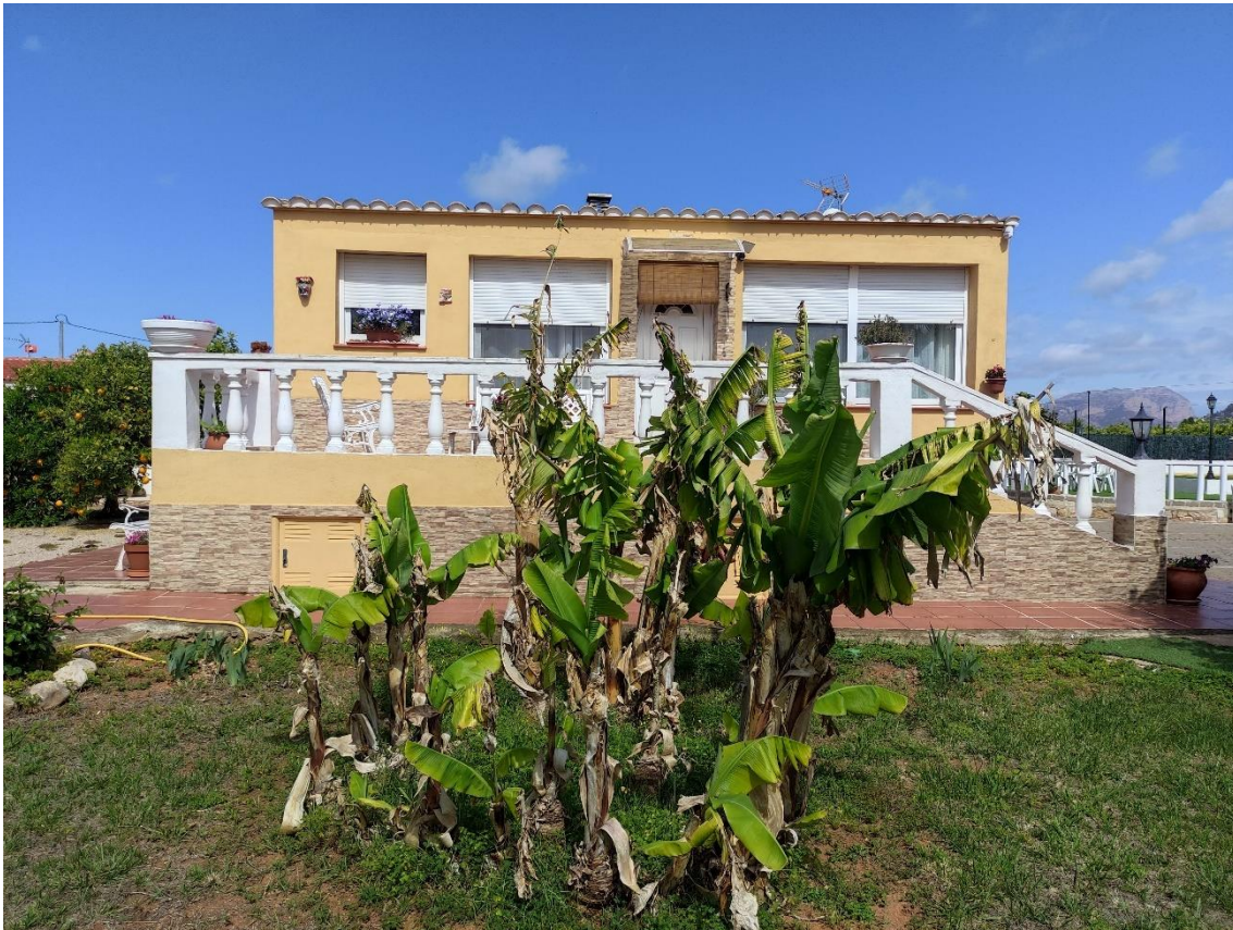
IMAGEN_05. Perspectiva de la vivienda tomada de la fachada orientada al suroeste. Se podría considerar la fachada principal de la misma. Existe una pequeña terraza a la cual se accede por una escalera. En esta zona destaca la presencia de una zona ajardinada.
