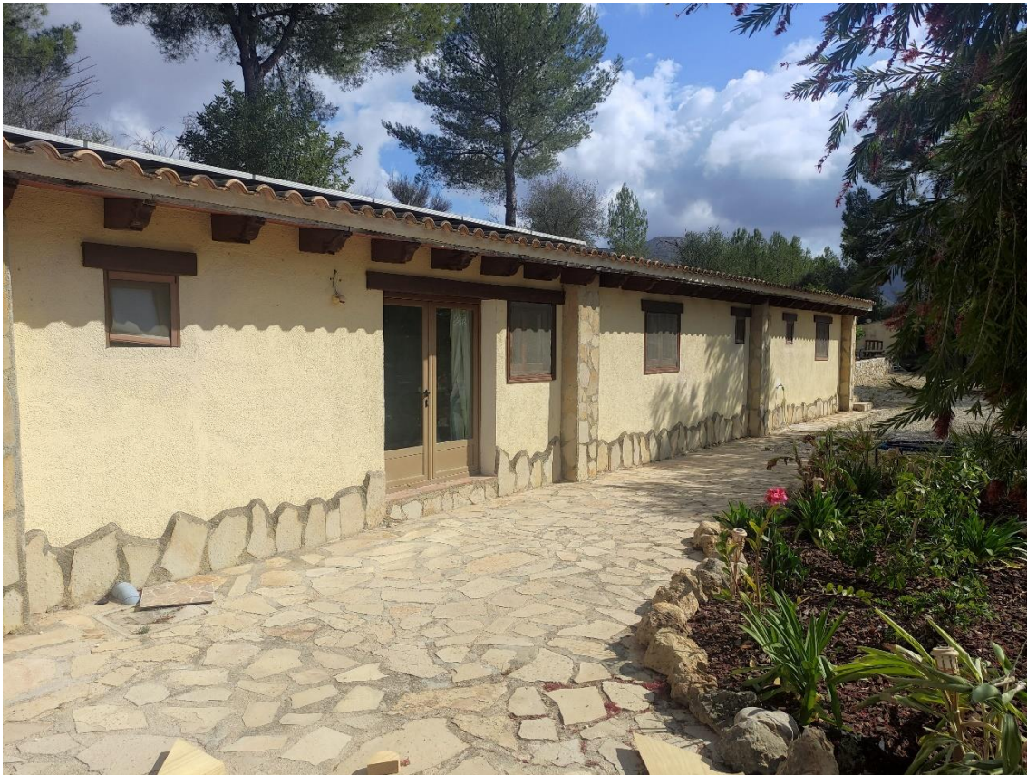
IMAGEN_02. Perspectiva de la vivienda tomada de la fachada orientada hacia el sureste. La edificación es de una sola planta. La cubierta inclinada se resuelve mediante utilización de teja árabe. Se aprecia la instalación de paneles solares fotovoltaicos para el suministro de energía eléctrica. La parte más cercana a la vivienda se encuentra pavimentada mediante piedra natural, de la misma manera que el zócalo de la edificación.
