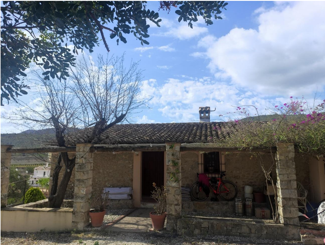
IMAGEN_04. Perspectiva de la edificación anexa tomada de la fachada orientada hacia el norte. En esta edificación destaca la utilización de piedra natural como solución constructiva.
