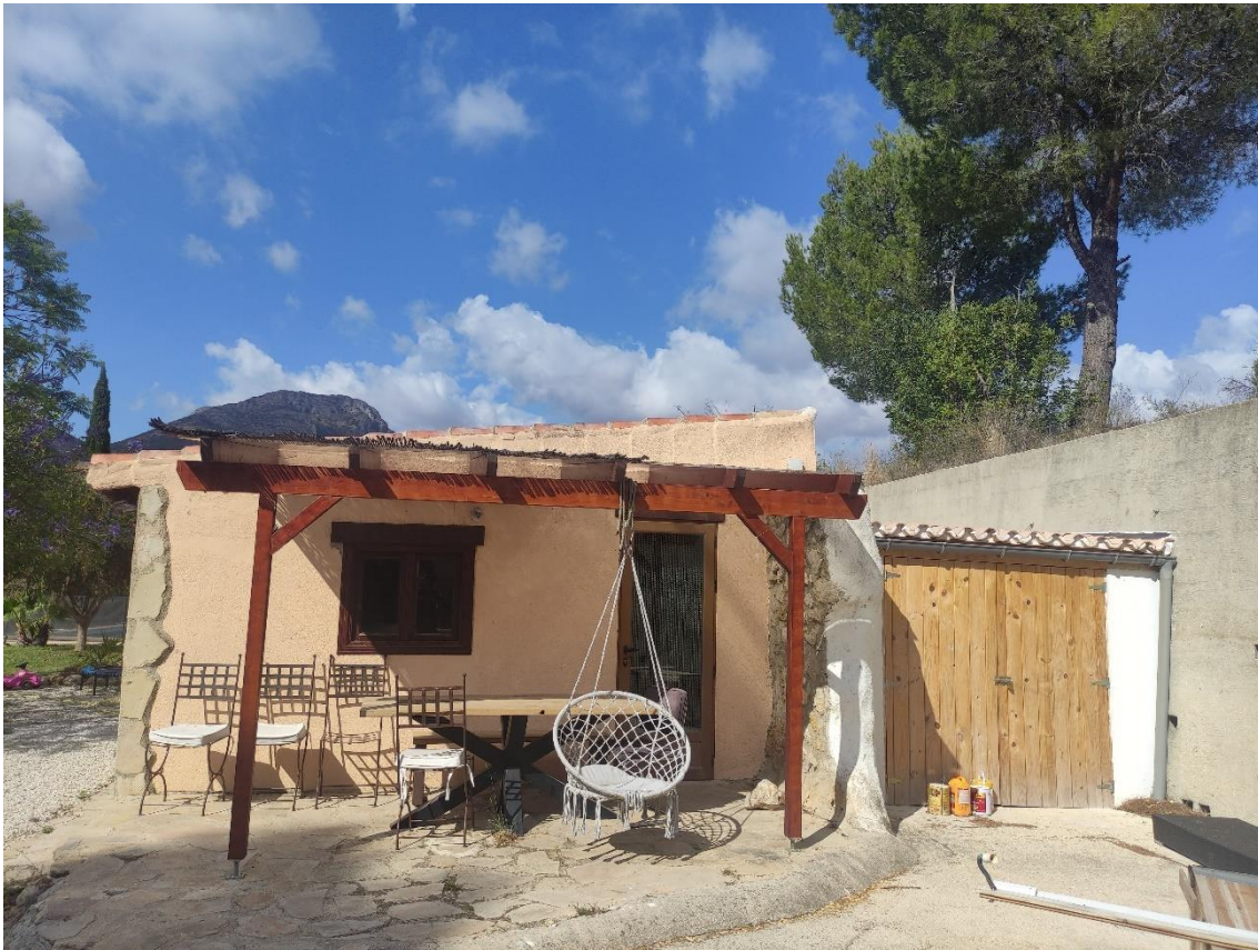
IMAGEN_03. Perspectiva de la vivienda tomada de la fachada orientada hacia el noreste. Se observa que la edificación está insertada en la pendiente del terreno. La cota superior donde se encuentran los ejemplares de pino, está a una altura superior. Los cerramientos se resuelven mediante la utilización de carpintería de aluminio en color madera.
